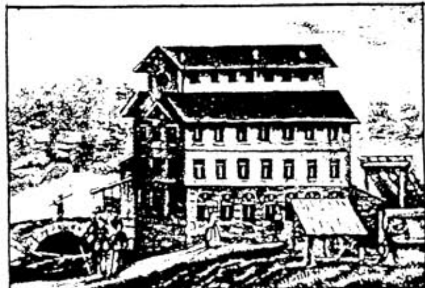
Die untere Fabrik
