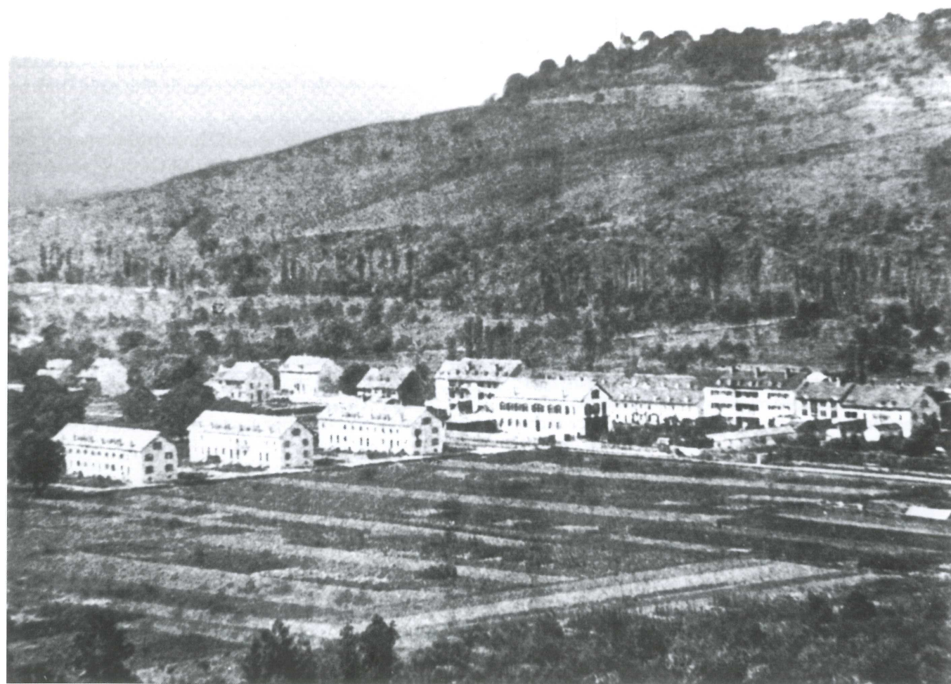
Fabrikarbeiterwohnungen, auch Laborantenhäuser genannt, der Stoffdruckerei Koechlin, Baumgartner & Cie. an der heutigen Schillerstraße im Lörracher Wohngebiet Neustetten, um 1870. Vorlage: Museum am Burghof, Lörrach
