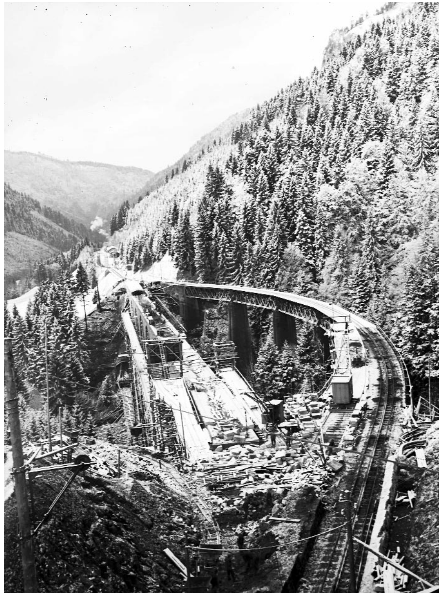
Arbeiten am neuen Viadukt der Höllentalbahn gegen deren Ende, mit der alten Brücke rechts, über die der Bahnverkehr auch während der Bauarbeiten weitgehend ungehindert verlief, 11. November 1927.
