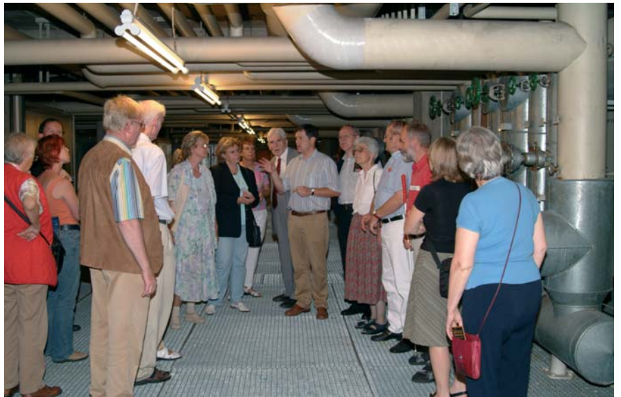
Besichtigung der gemeinsamen Klimazentrale der Württembergischen Landesbibliothek und des Hauptstaatsarchivs Stuttgart.
