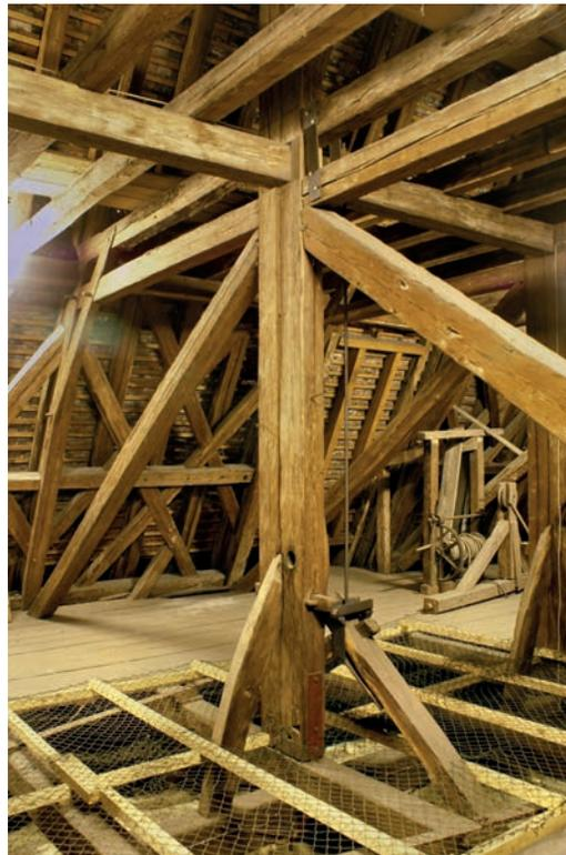
12 | Das Chorddachwerk, vermutlich 1480/81 begonnen, aber erst 1482 vollends aufgeschlagen, besitzt eine aufwendige, liegende Stuhlkonstruktion mit Hängewerk, das die Durchbiegung des Dachgebälks verhindern soll
